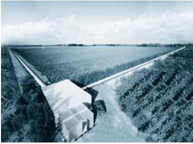
Abb. 10.51. Gravitationswellendetektor GEO600 bei Hannover (s. Abschn. 12.10.3). Der Blick erstreckt sich vom Strahlteiler des Michelson-Interferometers über die 600 m langen Arme (Mit freundlicher Erlaubnis von K. Danzmann, Universität Hannover)
