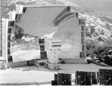
Der four solaire von Odeillo bei Font Romeu in den östlichen Pyrenäen. 65 nachführbare Planspiegel von je 48 \text{ m}^2 werfen das Sonnenlicht auf einen Parabolspiegel, in dessen Brennpunkt der Sonnenofen maximal 4000 \text{ K} erreicht
